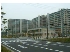
パークシティ東京ベイ 新浦安 Sol 街区(228)
