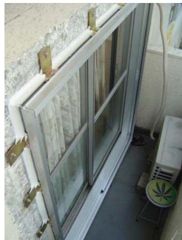
外付け工法によるバルコニーの掃出しサッシの2重化(工事中)
