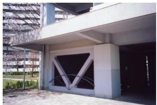
1階のピロティ部分を鉄骨プレースで補強
