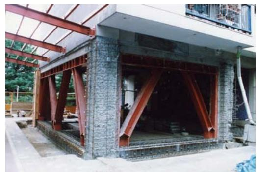
1階のピロティ部分の鉄骨プレース補強(工事中)
