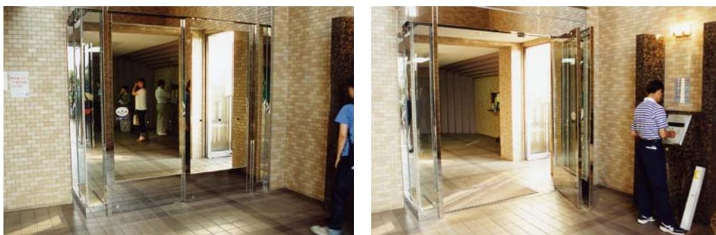
両開き扉をステンレス製片引きオートドアに変更(左)。大型荷物の搬入時には、
