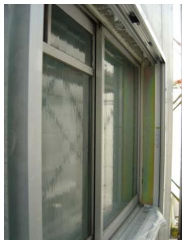
外付け工法による窓サッシの2重化
