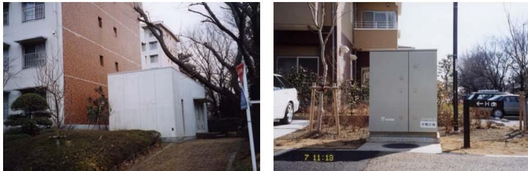
(左)借棟方式の変圧器室。設置スペースが必要。 (右)集合住宅用変圧器。
