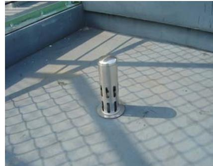
脱気装置(かぶせ方式・絶縁工法)
