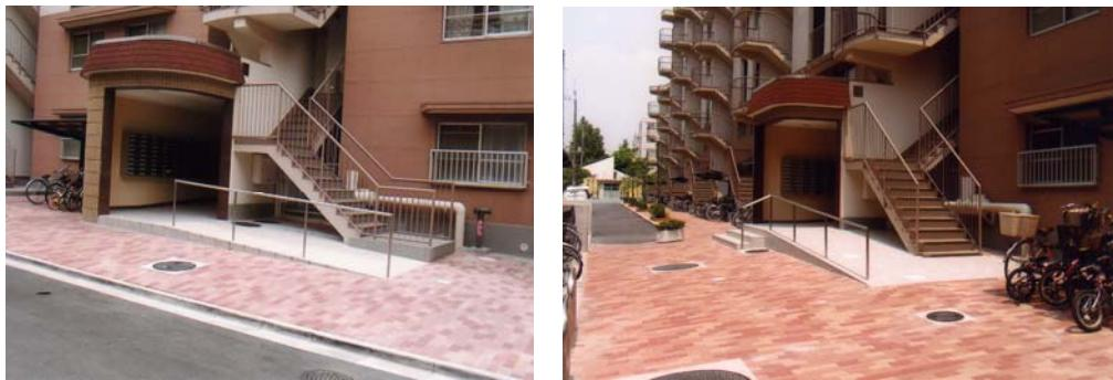
エントランスアプローチ部分の小段差にスロープを設置
