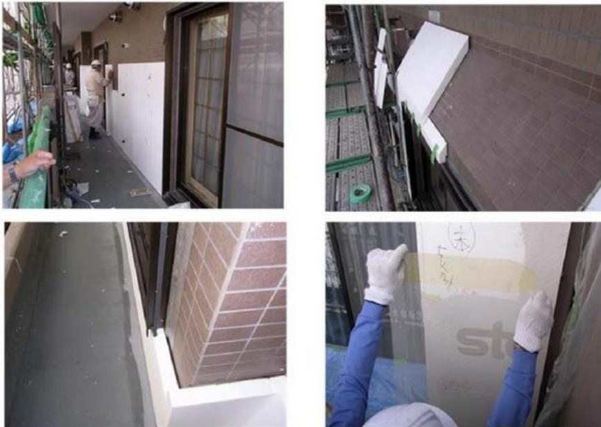
▲外壁の湿式外断熱／EPS断熱材の上にメッシュシート＋高耐久塗材
